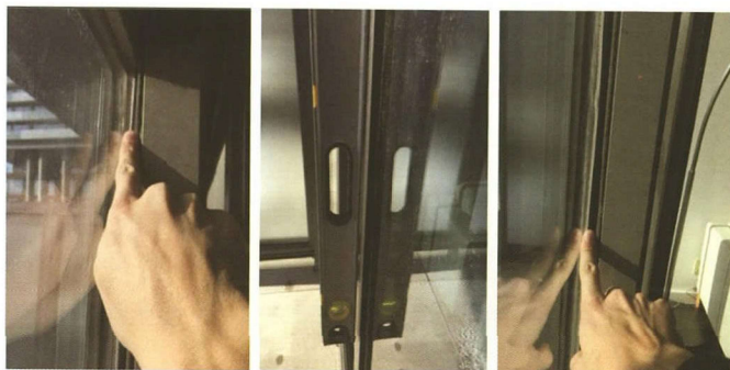
图 1 变形的推拉门型材
